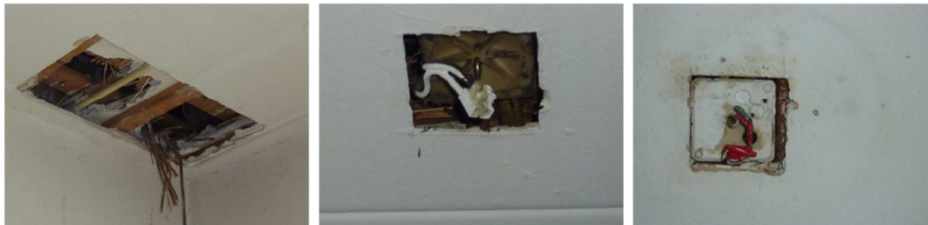
Opbouw onderzijde vloer – positie centraal dozen in het plafond
